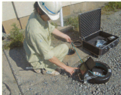
ファイバースコープによる管内状況確認
