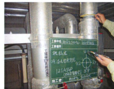
超音波測定機による配管肉厚測定作業状況
