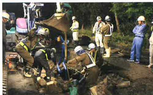
熊本地震の復旧活動の様子
