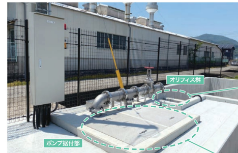
ポンプ据付状況
