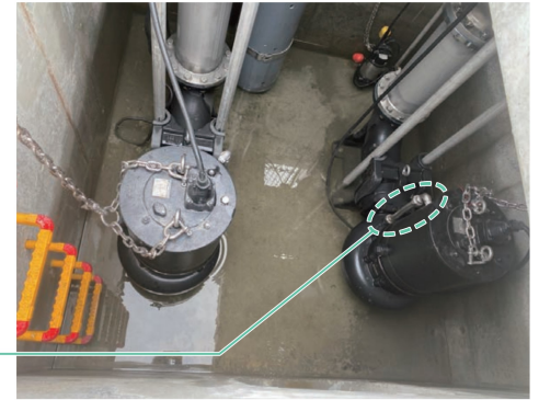
ポンプ据付状況
