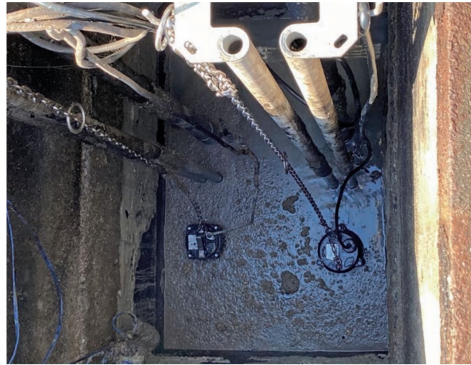
ポンプ据付状況
